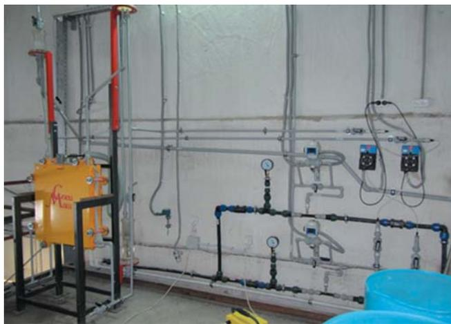
**Рис. 3. Электролизная установка на ВНС-252**
