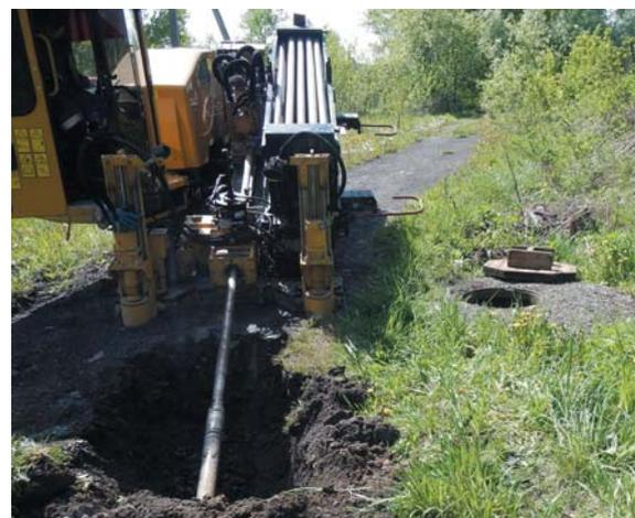
Рис. 2. Машина горизонтального направленного бурения *Vermeer*
