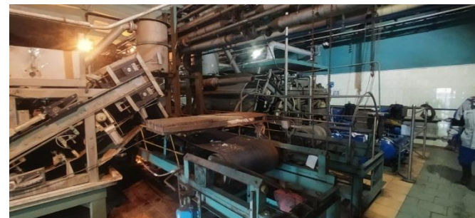
Фильтр-пресс, на котором происходит отжим сырого осадка с первичных отстойников
