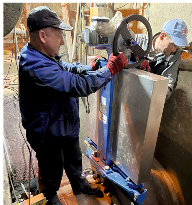
Установка шиберного затвора d-800
