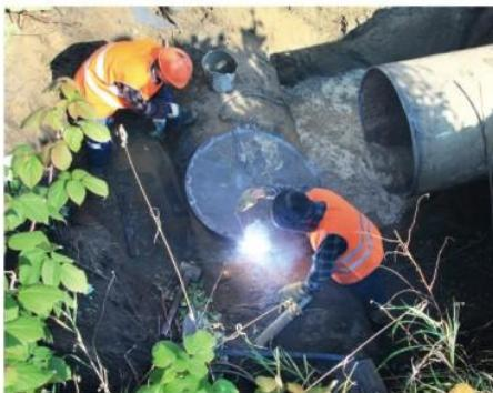
**31** июля специалисты Водоканала провели масштабные мероприятия по плановой замене запорной арматуры на магистральном водоводе диаметром 1 000 мм.
